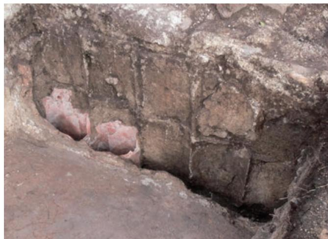
Hohlziegel zwischen Mauerwerk und Wandverputz ermöglichten eine Zirkulation der warmen Luft bzw. eine Temperierung der Wände
